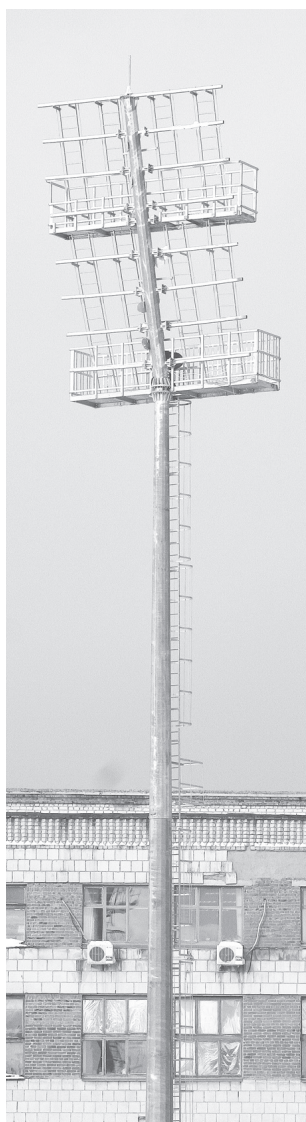
Установлены четыре новые осветительные мачты, на каждой из которых смонтировано по 41 современному прожектору производства Германии
